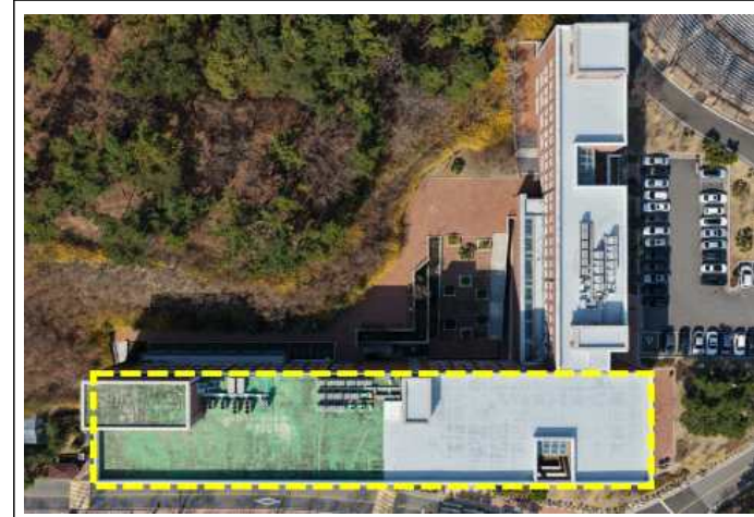
태양광 설치 위치
